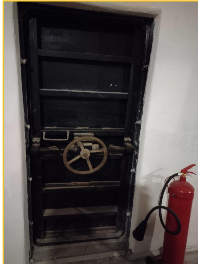
Проверка герметических устройств (дверей, люков, клапанов и пр.)
